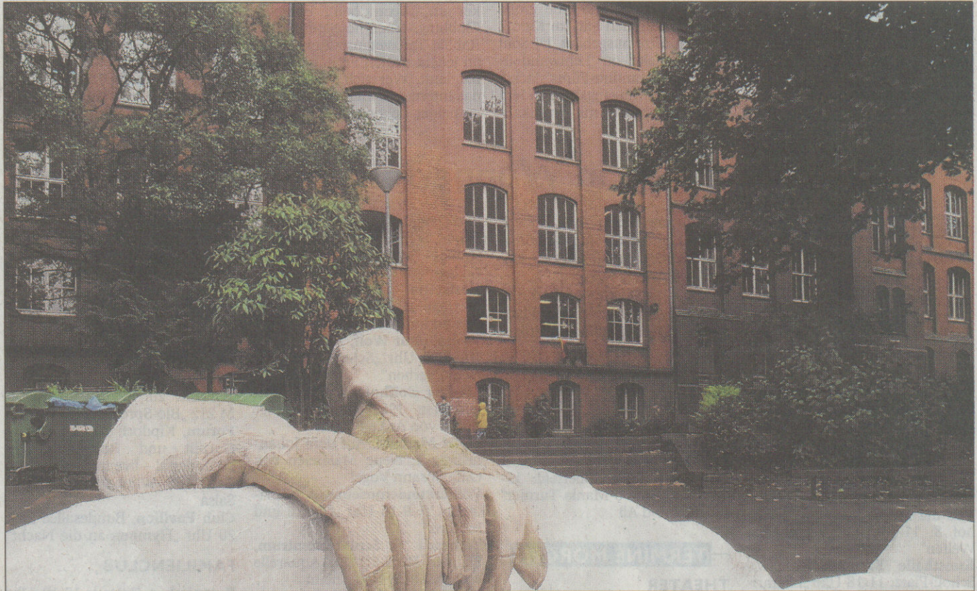
Willkommen im Club: Erstmals zählt die Grundschule Reichsgrafenstraße zu den Mammut-Baustellen der Sommerferien. Rund 2,14 Millionen Euro werden dort investiert - unter anderem in neue Fenster. Foto: Andreas Fischer
